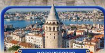
หอคอยกาลาดา
